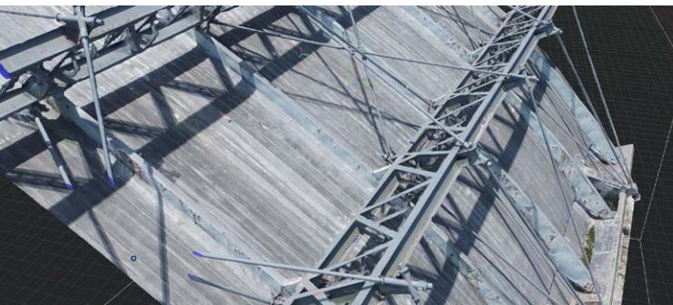
フォトグラメトリによって生成された屋根の筋交い部分
